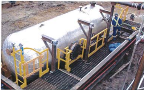
รูปที่ 2-13 ตัวอย่างและการทำงานของ Knock-Out Drum
