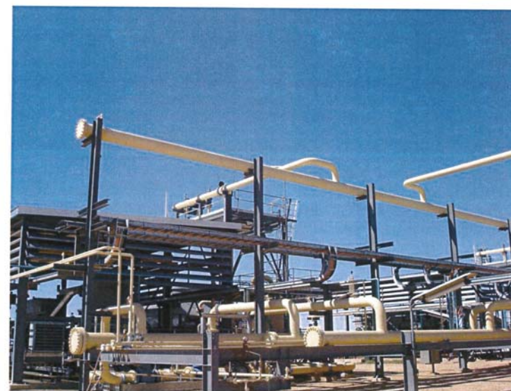
รูปที่ 2-12 ตัวอย่าง Flare Header
